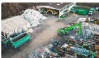
Monitoraggio di Discariche e Impianti di Trattamento dei Rifiuti
