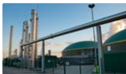
Rilevamento delle Perdite di Biogas
