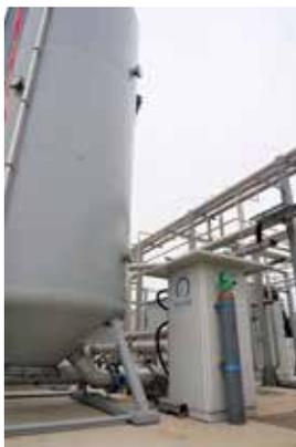
dei composti organici volatili (VOC) presenti in quantità variabile ma significativa nel biogas ottenuto dalla fermentazione anaerobica del materiale organico nei digestori. La committente necessitava quindi di un sistema di monitoraggio on-line dei VOC per determinare quando sostituire i carboni attivi nei sistemi di purificazione del biogas.
